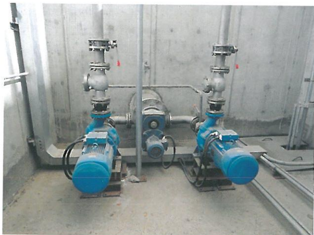
泥沙分离系统 去除0.05-0.2mm范围泥沙
