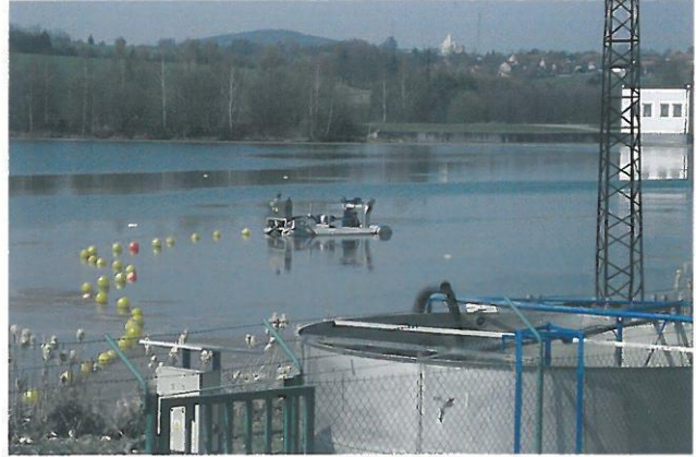
机器在河道内吸污清淤运行
